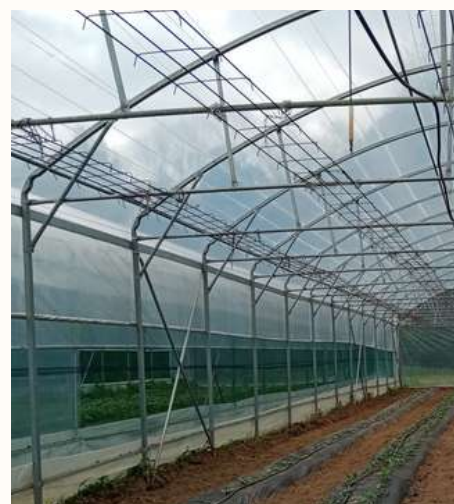
Palissage sur fers de béton
