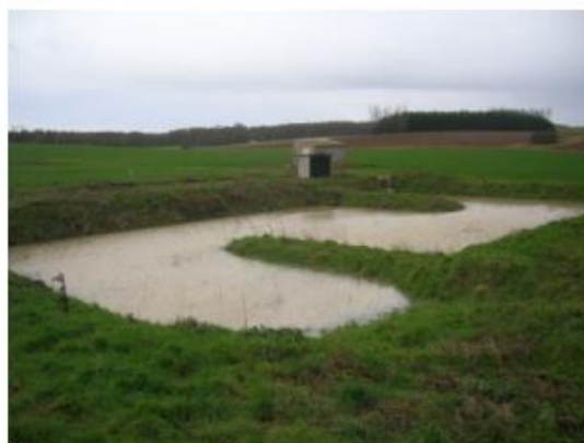
Figure 4 : Dispositif « mare-tampon en S »
