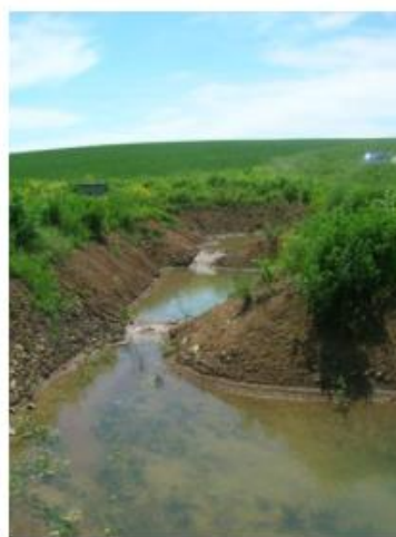
Figure 6 : Dispositif « linéaire en trois bassins »
